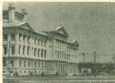
el centro del palacio legislativo, con el moderno edificio de las comisiones, en construcción.
