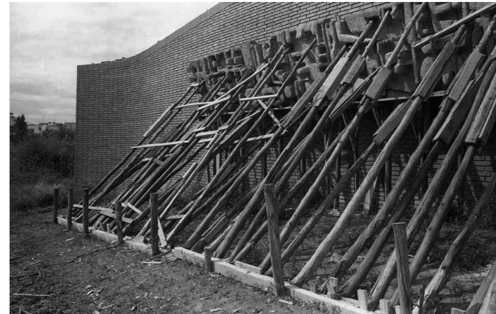
❖ Montaje y apuntalamiento de los paneles de hormigón en su ubicación definitiva. Archivo Fundación Cravotto (Reg.E2g.21_009). Publicada en la Tesis Final del DIPA - FADU, "Esculturas murales...", Arq. Valentina Odella.
