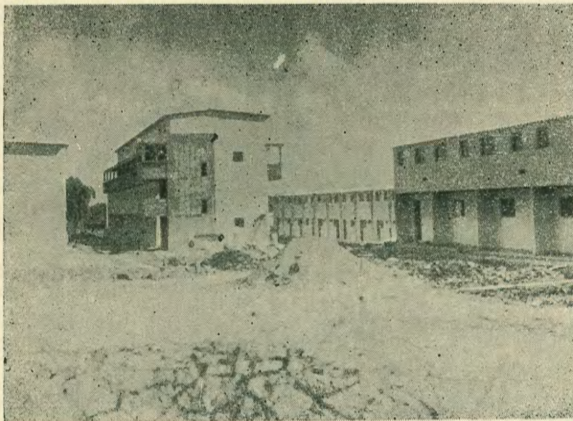
Viviendas de la segunda etapa del P.N.V. de baja calidad.
