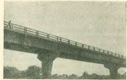
puente del san luis, ruta 19.
